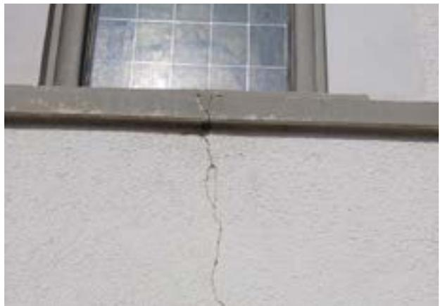
An mehreren Stellen des Kirchengebäudes müssen im Verputz entstandene Schäden saniert werden. Nach dem Ausmalen der Kirche im Jahr 1978 ist wieder ein Reinigung der Raumschale erforderlich.
